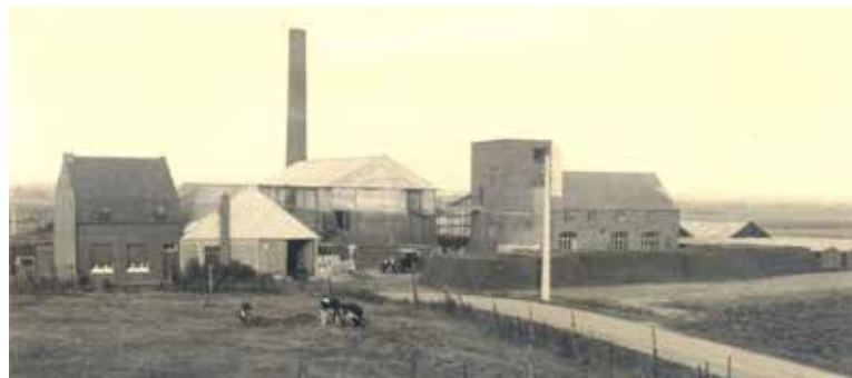
De Buizenfabriek in de jaren 1930 met centraal de ringoven.
